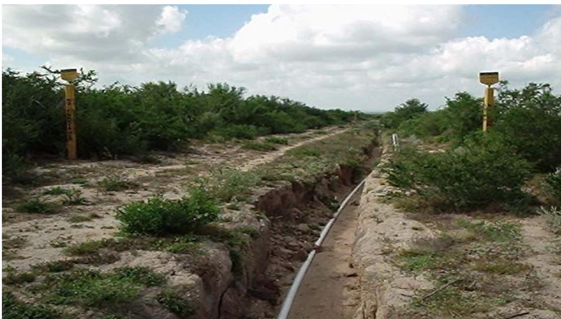
FOTO No. 2.- Tubos de conducción de gas o hidrocarburos descubiertos por el arrastre del suelo.
