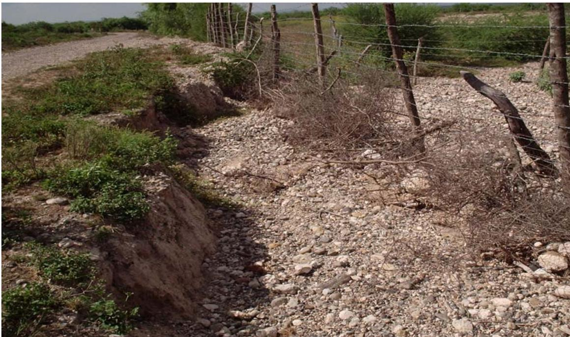
FOTO No. 5.- Represas filtrantes colocadas en algunos predios en mal estado.
