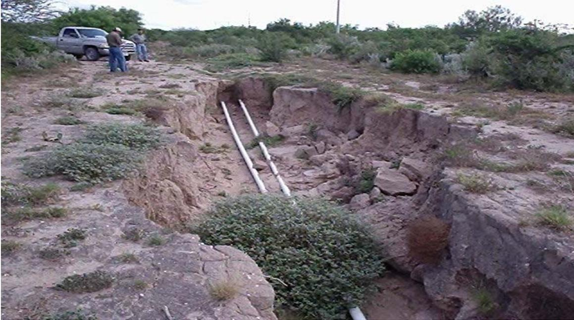
FOTO No. 3.- Por la falta de cobertura vegetal y la acción de la lluvia, se presentan problemas de derrumbes.
